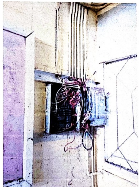
ภาพประกอบการชำรุดของระบบไฟฟ้าภายในอาคาร 2 และอาคารอุตสาหกรรม
